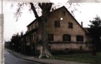
◀ Corps de ferme remarquable par la justesse de son échelle et la qualité de ses abords au contact du carrefour de l'Europe
